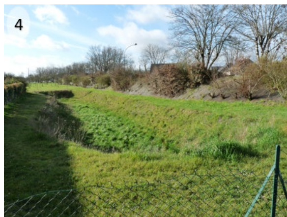
Bassin de rétention existant au nord du site
